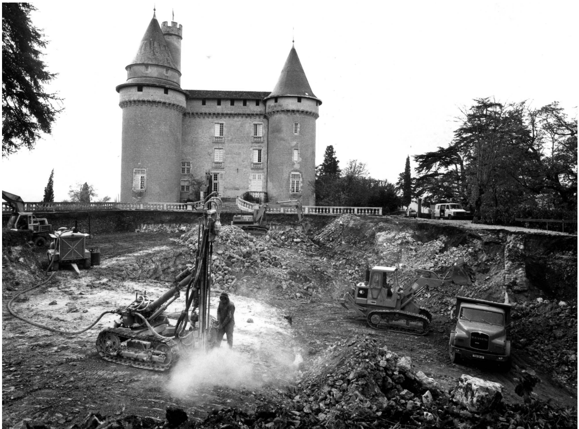
Hiver 1986-1987 : creusement du chai du Château de Mercuès sous les jardins du château
